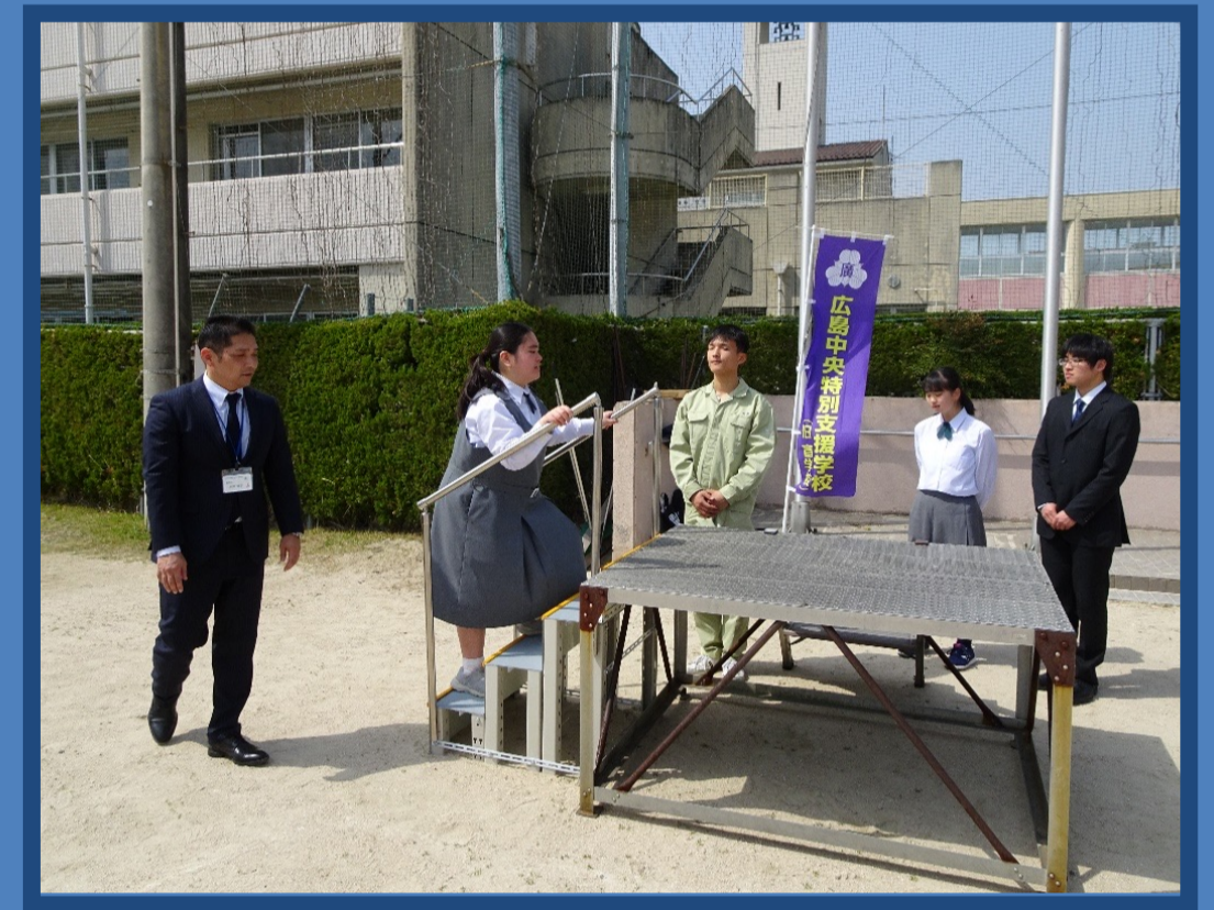
特別支援学校の朝礼台の階段に手すりを取り付けた後、試してもらっている様子
